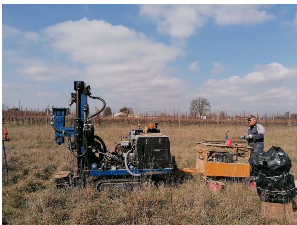
Figura 14 – sondaggio S5-pz2, piazzamento sonda
