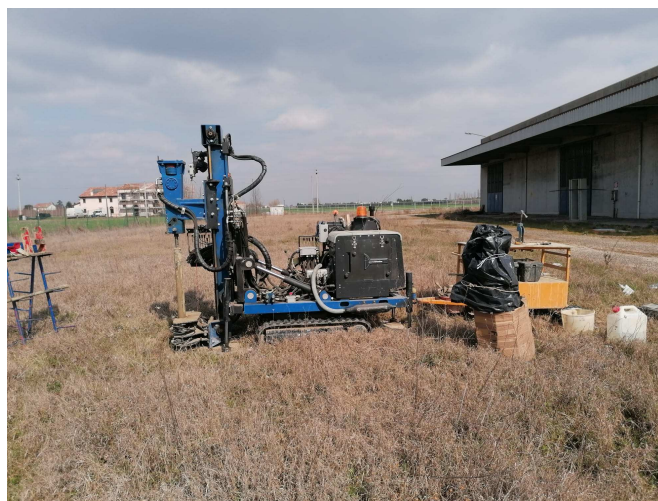
Figura 5 – sondaggio S1, piazzamento sonda
