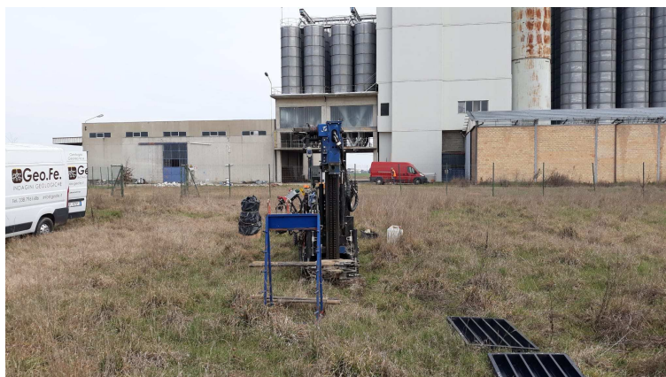
Figura 11 – sondaggio S4-pz1, piazzamento sonda
