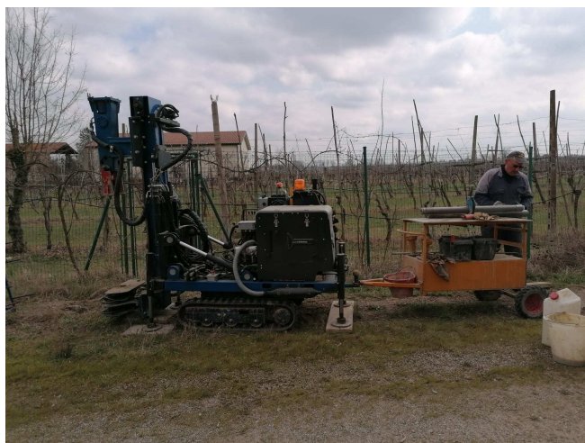
Figura 9 – sondaggio S3, piazzamento sonda
